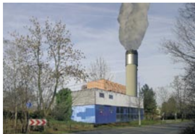
Problem Kamin ohne Filter
